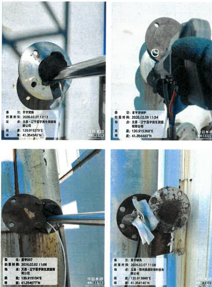
有组织废气采样照片
